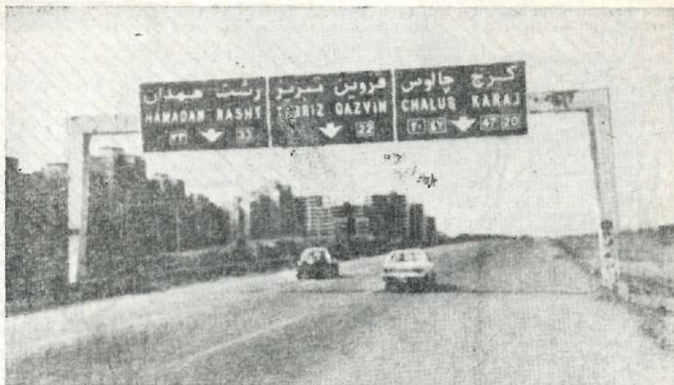
Рис. 2. Участок дороги А1 в районе Тегерана
